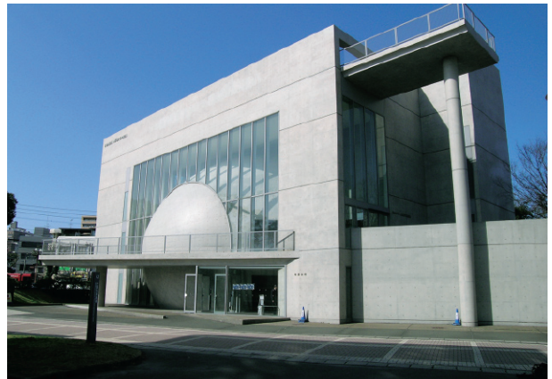
郡元キャンパス「工学部通り」より。 午前光を受ける姿は輝かしい。 タマゴの上半分は当時最新の高流動コンクリート 2) 。
