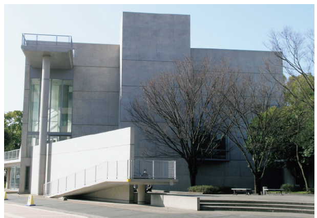
北側は広場が設けられていて憩いの場である。 手前のRC壁に沿って設けられたスロープが見える。 屋上から突き出た展望デッキが孤立を拒むよう。
